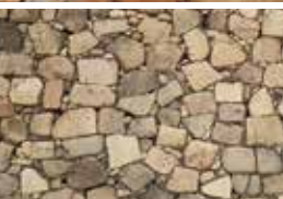
打ち込みはぎ (徳川大坂城/西外堀石垣) (第1期工事)
