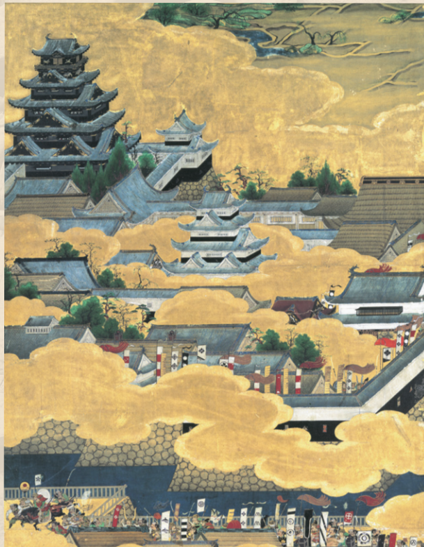
大坂夏の陣図屏風(重要文化財) 大阪城天守閣蔵
