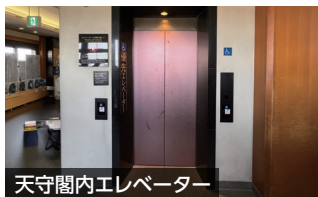
天守閣内エレベーター
